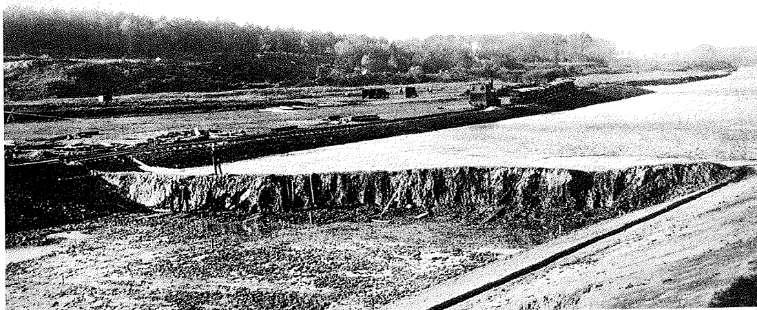
Zum Foto über diesem Text: Für den Ablauf des Gahlener Mühlenbaches musste erst ein Düker gebaut werden. Das Bild zeigt die Baustelle nördlich des Gahlener Overbeckshofes. In Querrichtung verlief später das Kanálbett.
