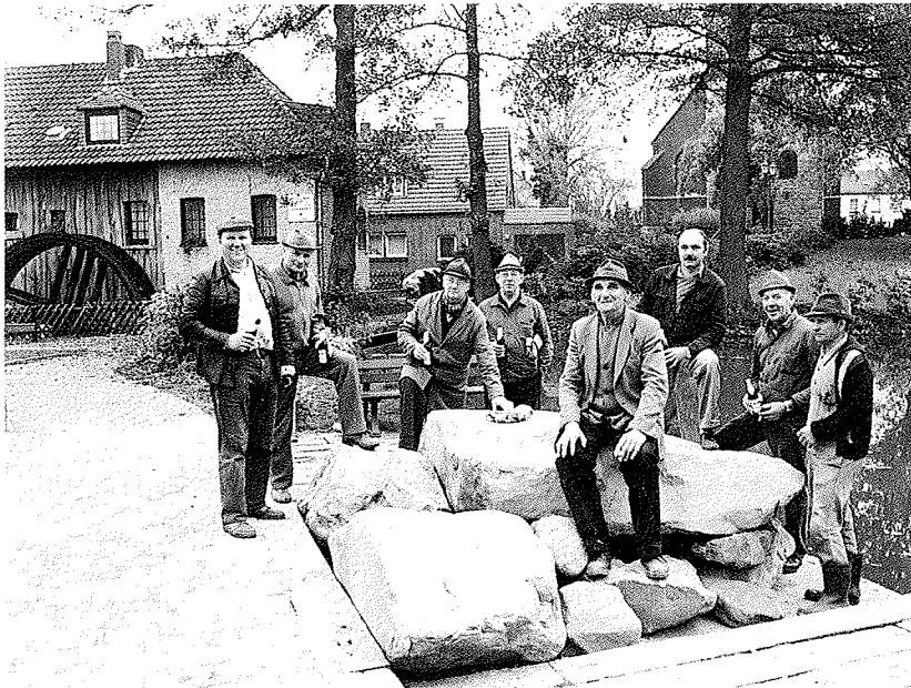
Aus mächtigen Steinen wurde der neue Brunnen von Mitgliedern des Heimatvereins zusammengesetzt.
