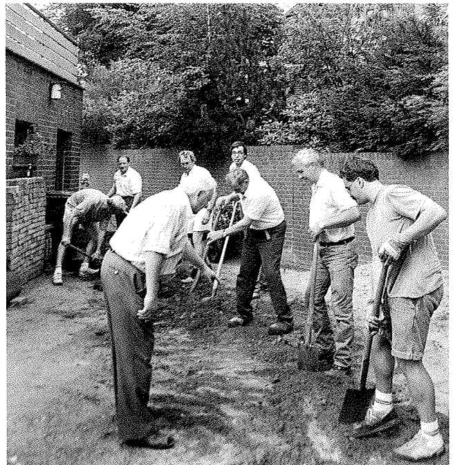
Zum Foto: Im August 1991 wurden die Arbeiten für die Beleuchtung der Dorfkirche ausgeführt.
